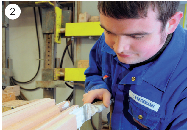
2 Der Geselle trägt Leim auf, der die einzelnen Teile des Fensterflügels später zusammenhält.
