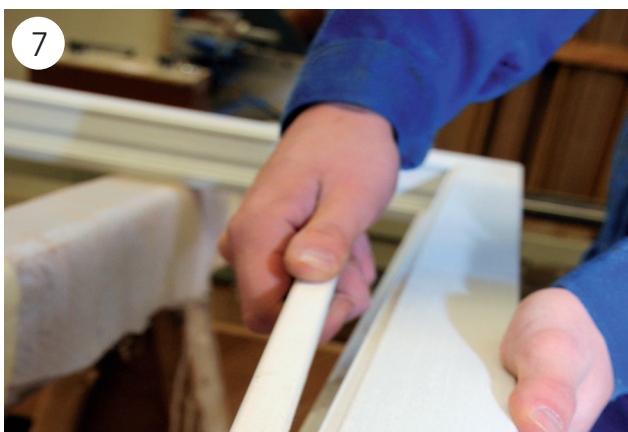
7 Die Glashalteleisten werden provisorisch in den Fensterflügel eingesetzt. Auf der Baustelle werden sie noch einmal entfernt, um die Glasscheiben einzusetzen. Danach werden sie endgültig befestigt.
