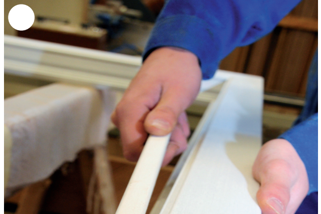
Die Glashalteleisten werden provisorisch in den Fensterflügel eingesetzt. Auf der Baustelle werden sie noch einmal entfernt, um die Glasscheiben einzusetzen. Danach werden sie endgültig befestigt.
