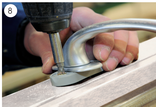
8 Zum Abschluss der Fensterproduktion in der Tischlerei werden die Scharniere und Griffe am Fenster montiert.
